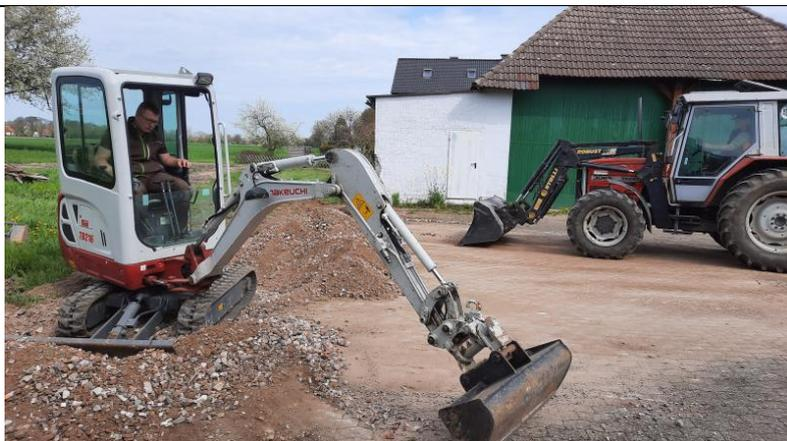
Hier geht's los – der Boden ist schon ausgehoben, Schotter wird eingefüllt.
