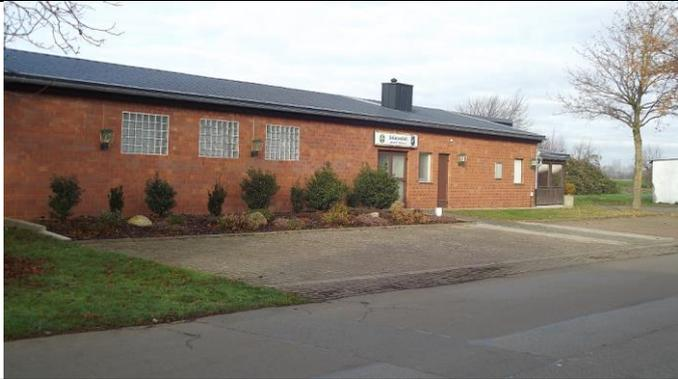
Renovierung unserer Schützenhalle – in 2020 wurde bereits das Dach erneuert und als energetische Maßnahme eine Einblasdämmung eingebracht. Das neue Dach ist hier schon zu sehen. Die bisherige asbesthaltige Bedachung wurde entsorgt. Durch das Land NRW geförderte Maßnahmen: Dach und Dämmung, Renovierung der Toilettenanlagen.
