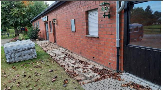
Hier der Bereich vor der Halle – der bislang an der Außenwand liegende Telefonanschluss wurde nach innen verlegt. Die Waschbetonplatten sind schon entfernt und die neuen Steine stehen bereit.
