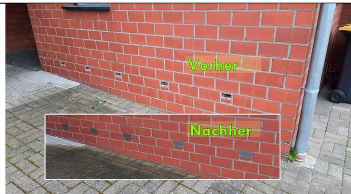
Noch ein Bild unserer Renovierungsarbeiten: Die Öffnungen der Luftschlitze in den Wänden rund ums Gebäude sind in der Vergangenheit von „bösen Buben“ zerstört worden. Inzwischen wurden gelöcherte Abdeckplatten aus Metall montiert.
